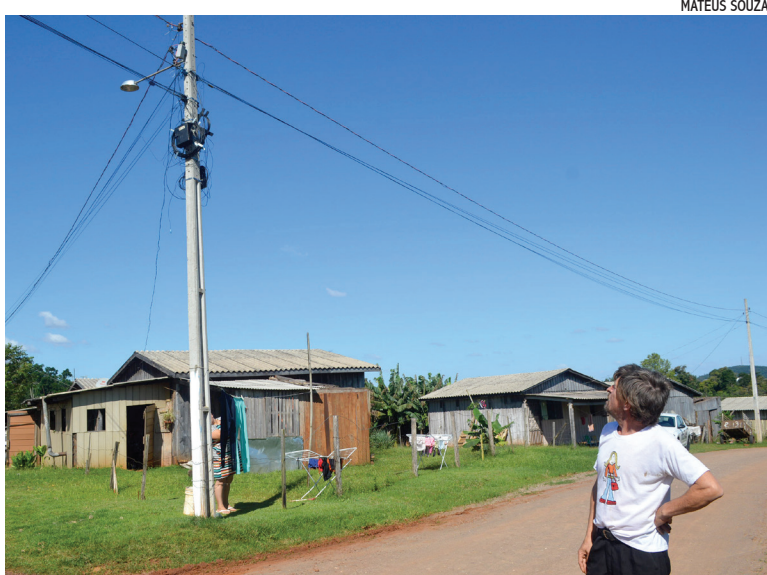
Um dos postes com lâmpada queimada está em frente a casa de Voigt
