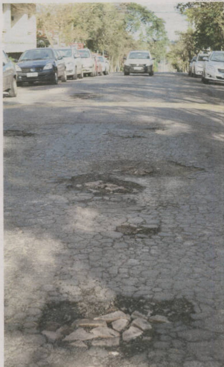
Sosur começa reparos pelas ruas João Abott (foto) e Castelo Branco
