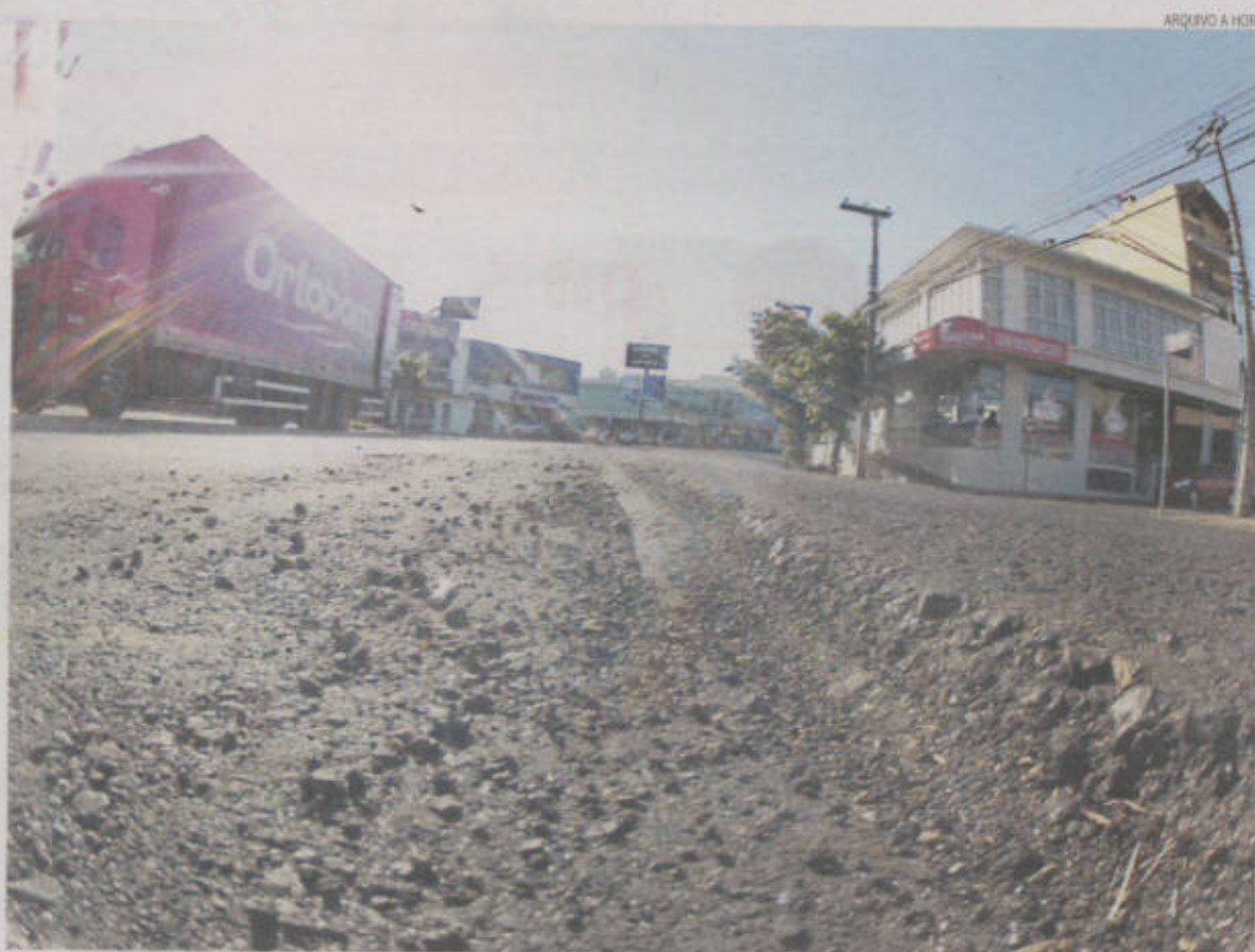
Entre as principais obras previstas no contrato, está o recapeamento da av. Benjamin Constant. Serviços já iniciaram
