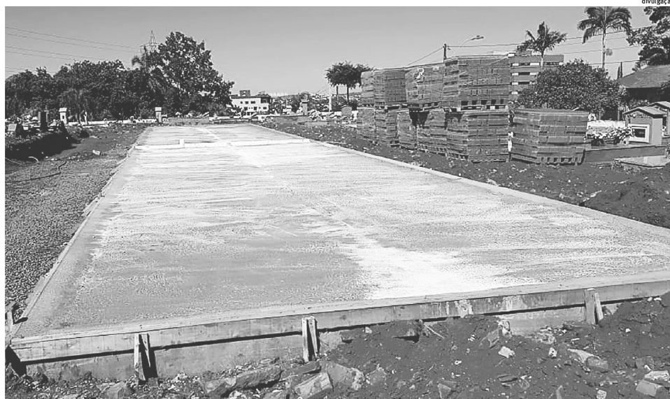
AMPLIAÇÃO: obra do novo bloco de gavetas deve ser concluída em outubro de 2019
