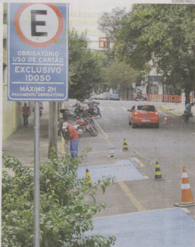
Serviço deve ser concluído amanhã e prevê a sinalização de 91 espaços
