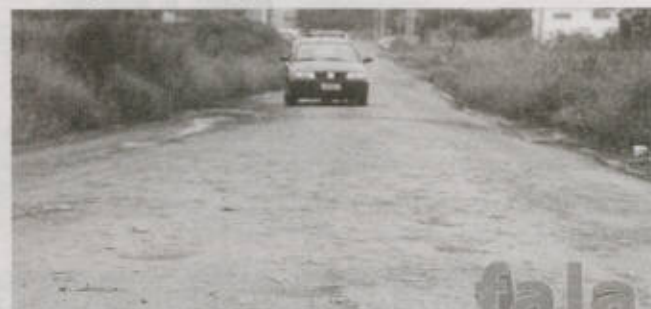
Morador reclama da falta de patrolamento e colocação de material na Rua A, no Bairro Bom Pastor
