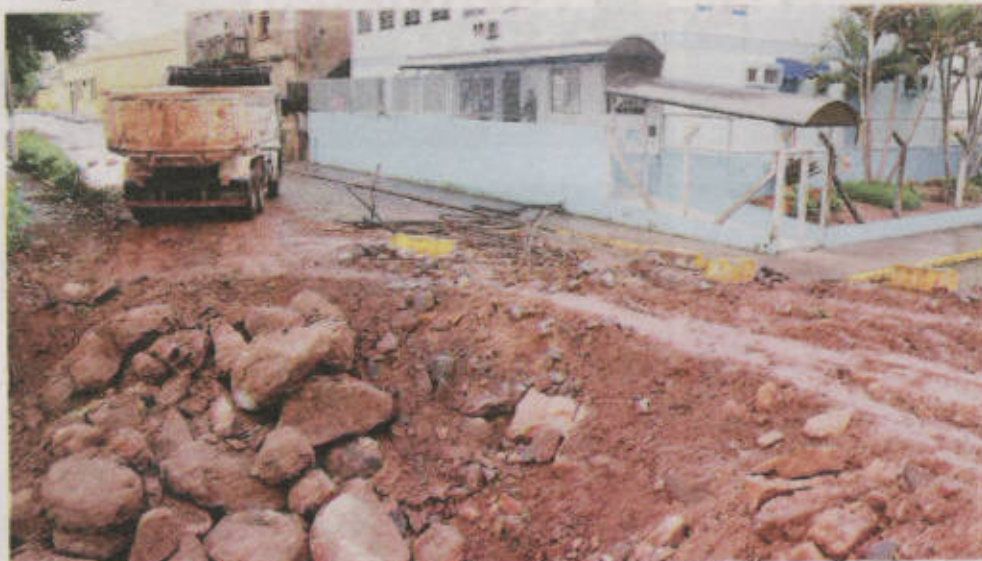
Secretaria de Obras trabalha na recuperação da barranca do Rio Taquari
