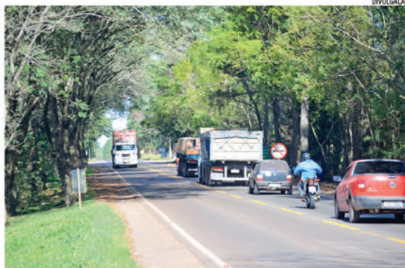
Principal acesso aos bairros, ERS-128 deverá ter trevo e duas rótulas
