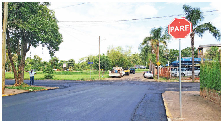
Obras na quarta-feira se concentraram na área central da cidade
