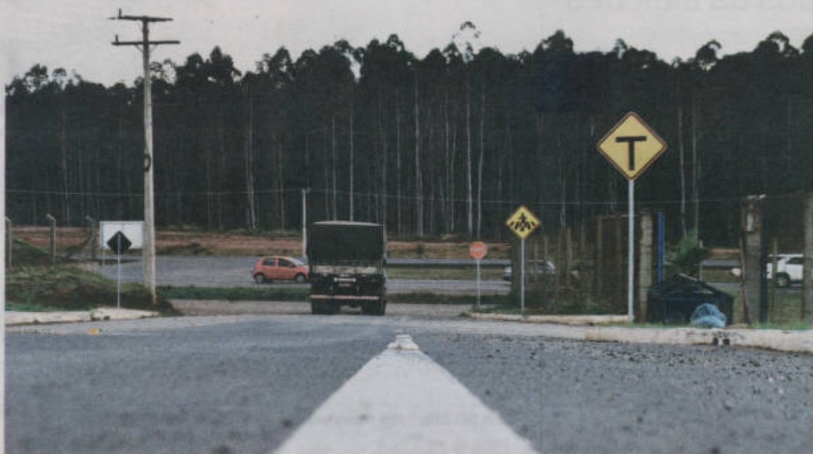
Nova cobertura melhorou as condições de trabalho na região. Usuários criticam a falta de redutores de velocidade na rua
