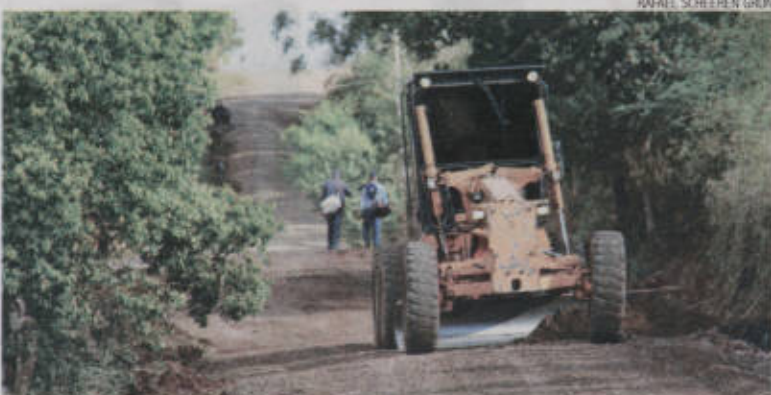
Limpeza da via, valetas e patrolamento fazem parte da restauração da via
