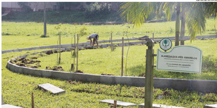
TRABALHOS: construção no Jardim Botânico é executada pela Companor Construções
