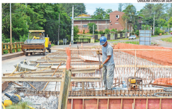
Funcionários fizeram ontem a armação na entrada da passagem
