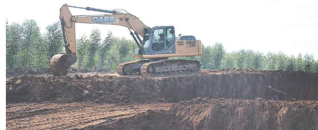
Terraplanagem vai possibilitar a construção de estrutura
