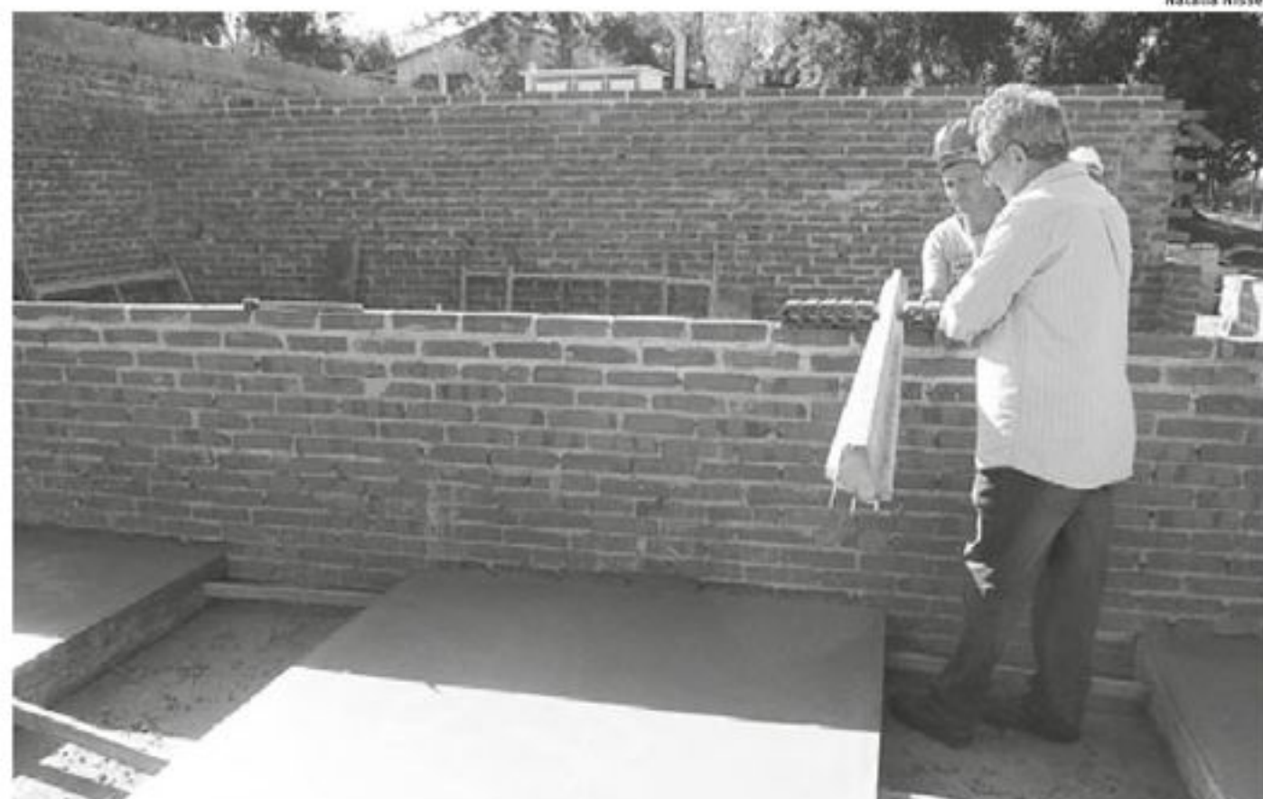
TRABALHO: obra do novo albergue já está na fase de construção dos triliches
