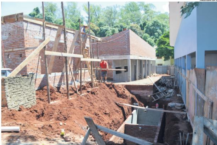
Obras de construção de quatro salas iniciaram em julho do ano passado e deveriam ter sido finalizadas em janeiro
