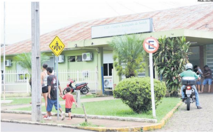
Administração municipal estuda a viabilidade de comprar o imóvel onde funcionava o antigo hospital Redentor
