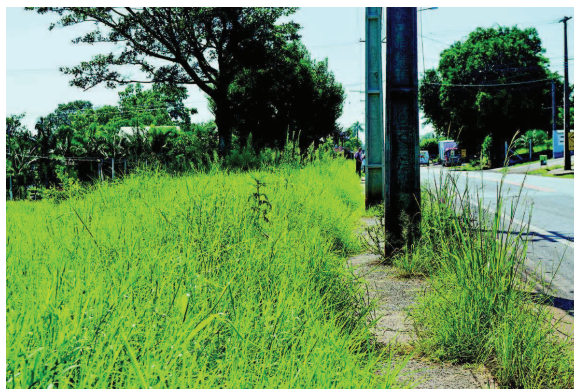
Calçadas ao longo da rodovia apresentam problemas de acessibilidade
