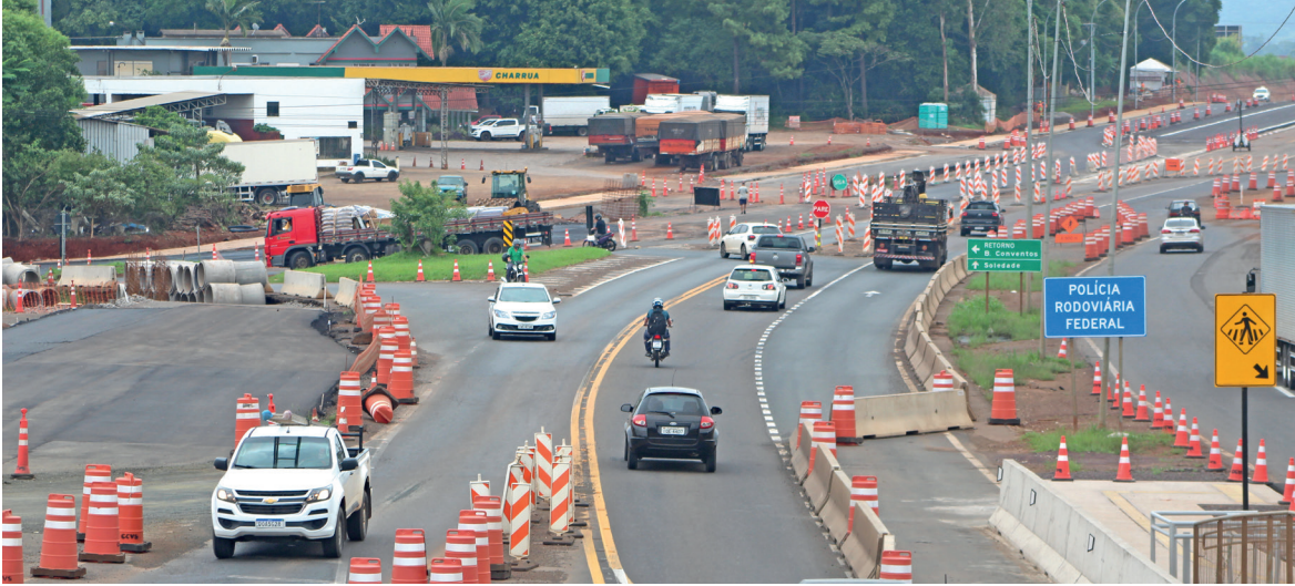
Sinalização será reforçada a partir de amanhã, com bloqueio na faixa que dá acesso à Pedro Theobaldo Breidenbach
