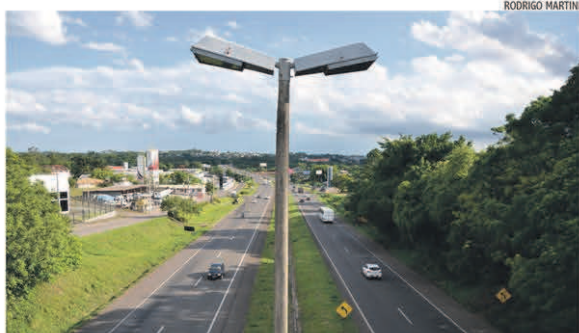
Obras devem iniciar nos próximos dias. Prazo da 1ª fase é de três meses
