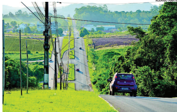
Obras em 14 ruas e duas avenidas foram realizadas entre 2015 e 2018
