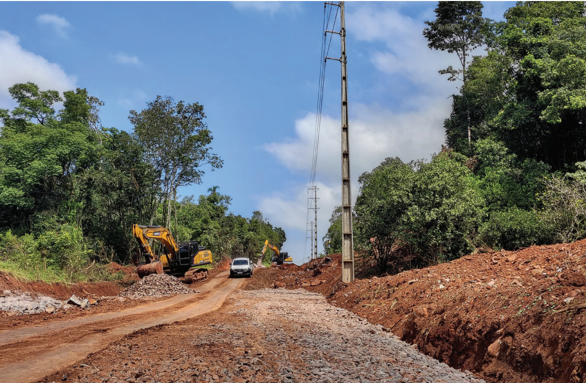
Obra também vai demandar a remoção dos postes de energia. Objetivo é desviar fluxo dos bairros
