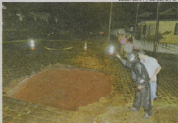
Em Lajeado, uma cratera se abriu na rua São Paulo
