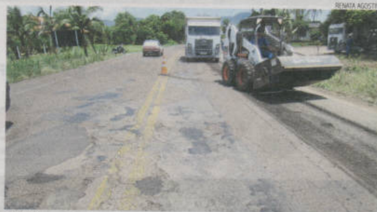
Pela 1ª vez o trecho recebe recapeamento. Até então, foram só tapa-buracos
