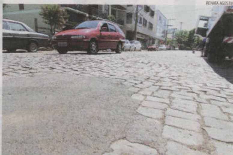
Obra na Av. General Daltro Filho inicia em janeiro. Investimento é de R$ 115,5 mil
