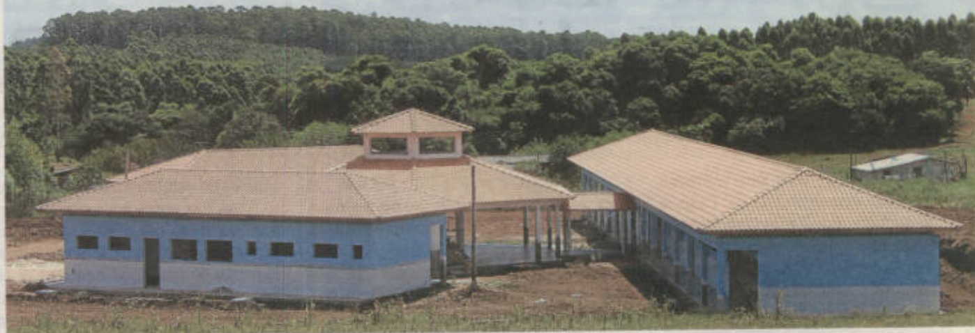
Escola do Bairro Morro Bonito
