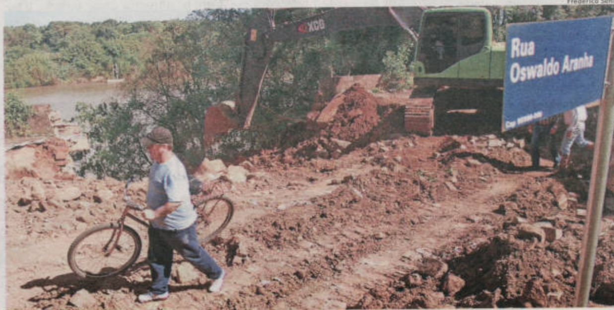
Obra exige pressa, pois estragos podem ser maiores numa próxima enchente
