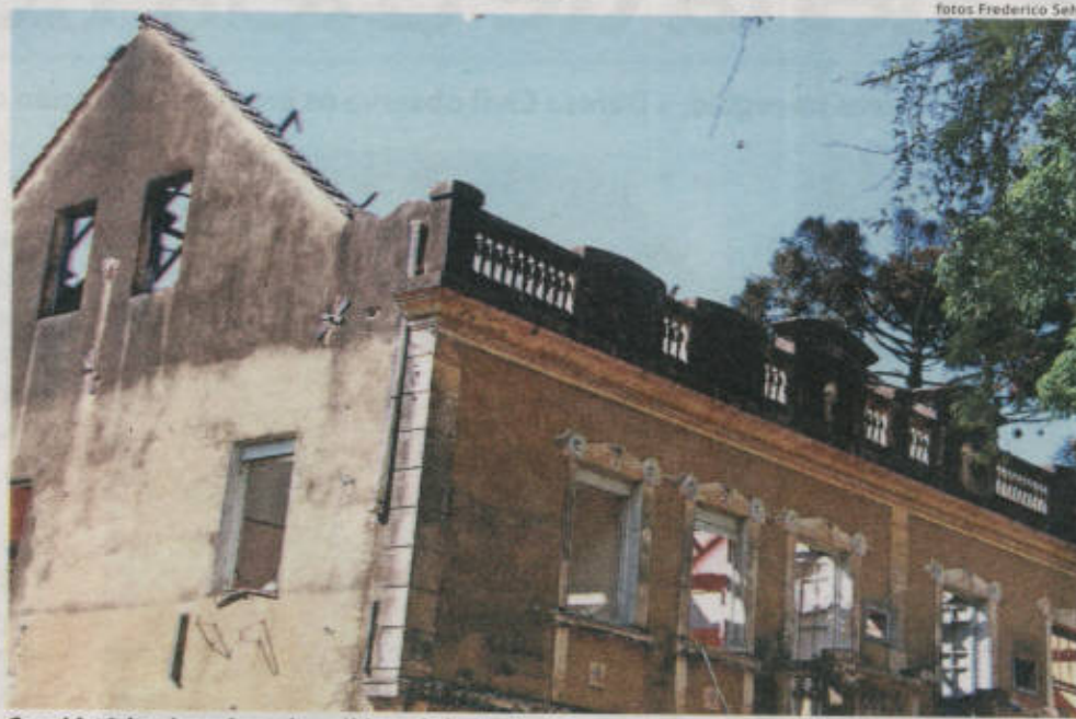
Casa histórica deverá ser demolida após incêndio
