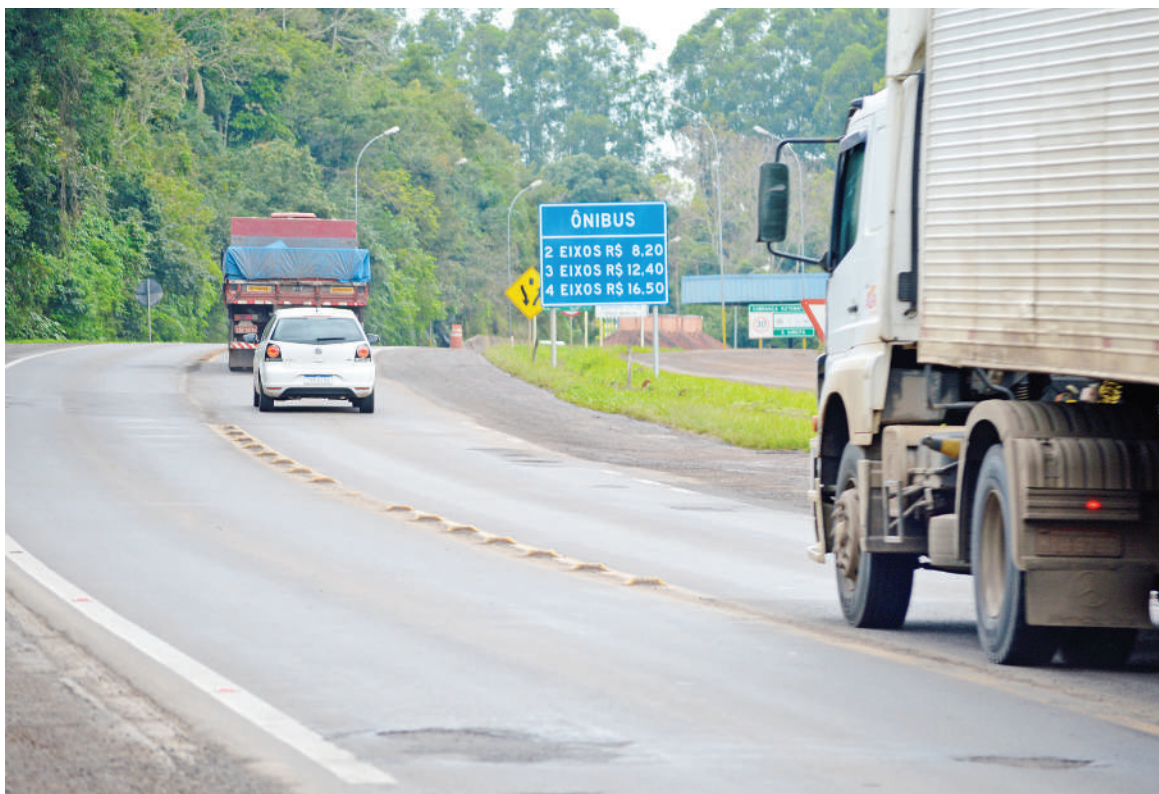
Trecho entre Lajeado e Encantado é considerado um dos mais críticos da infraestrutura regional
