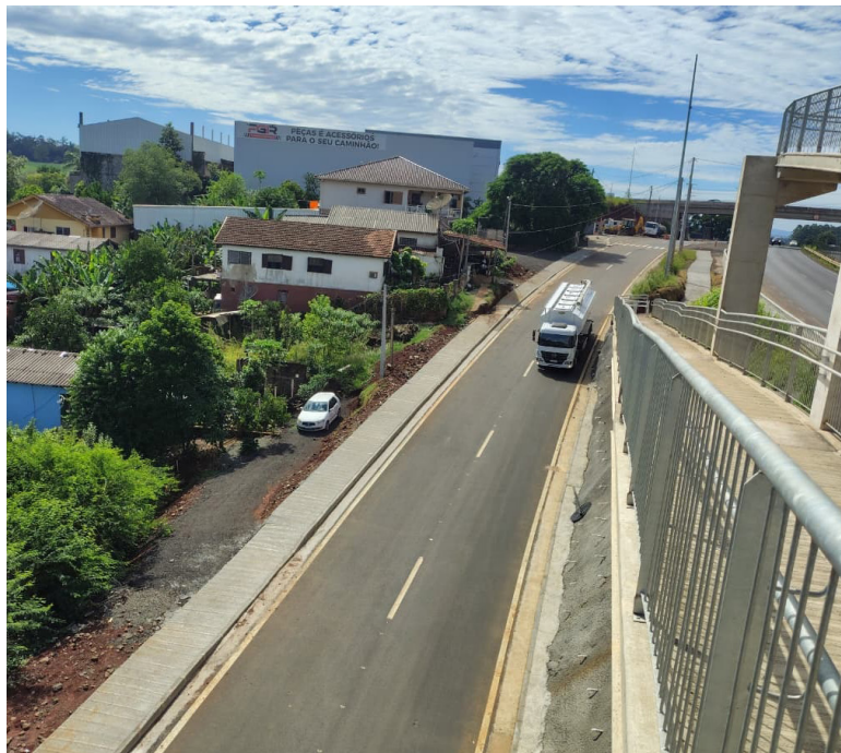
Liberação ocorreu após a conclusão do asfaltamento da pista lateral
