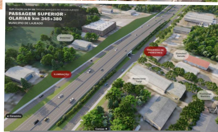
Última intervenção prevista para este novo prazo será a readequação da estrutura elevada no bairro Montanha
