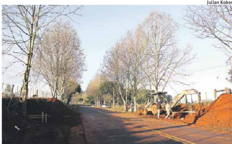
OBRAS: fundações já começaram a ser feitas no local previsto inicialmente
