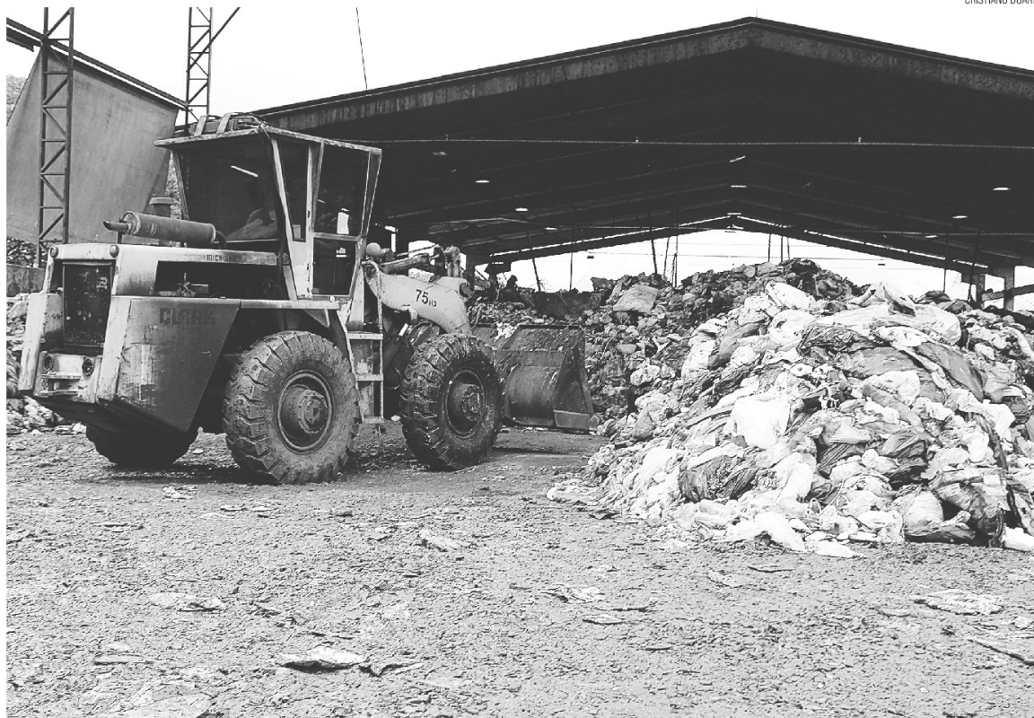
Das três células de tratamento de resíduos, apenas uma funciona e tem vida útil por apenas mais um ano e meio
