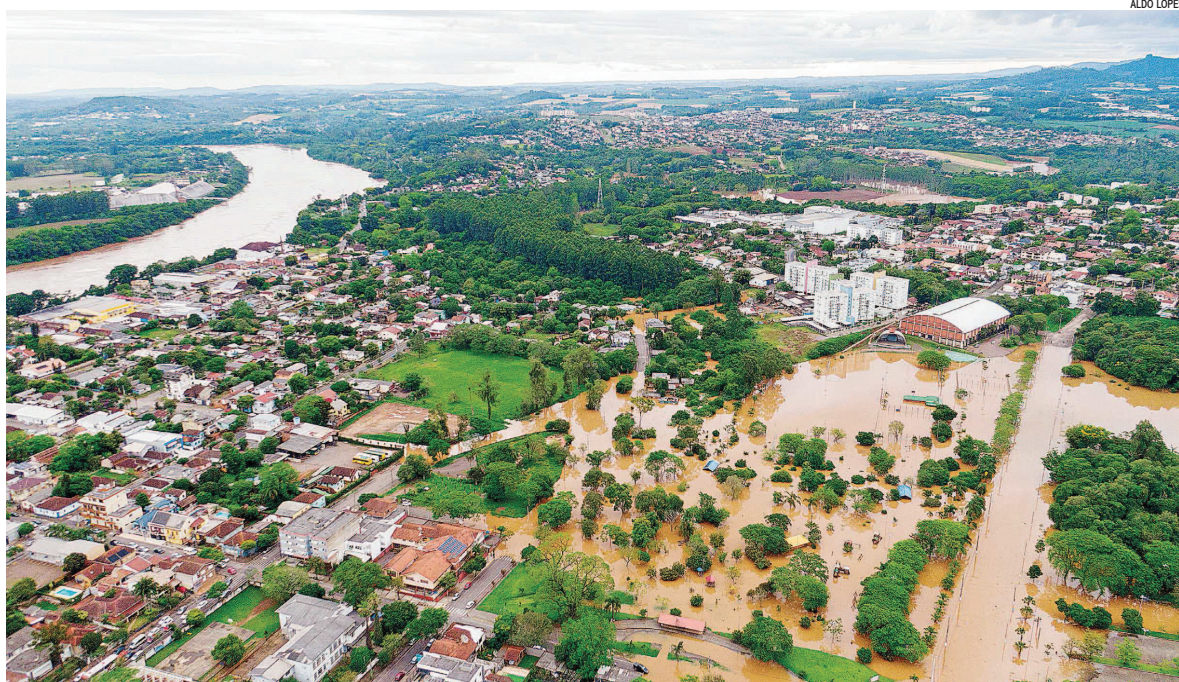
Cheia alagou diversos pontos de Lajeado. Além de cerca de 20 famílias removidas de suas casas, água inundou ruas e quase todo o Parque dos Dick
