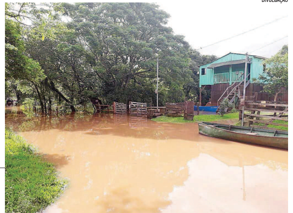
Casas na Rua Franklin Filho foram atingidas pela cheia em Taquari
