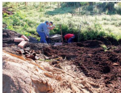
Canalização pluvial e caixa coletora foram instaladas na rua Sarandi
