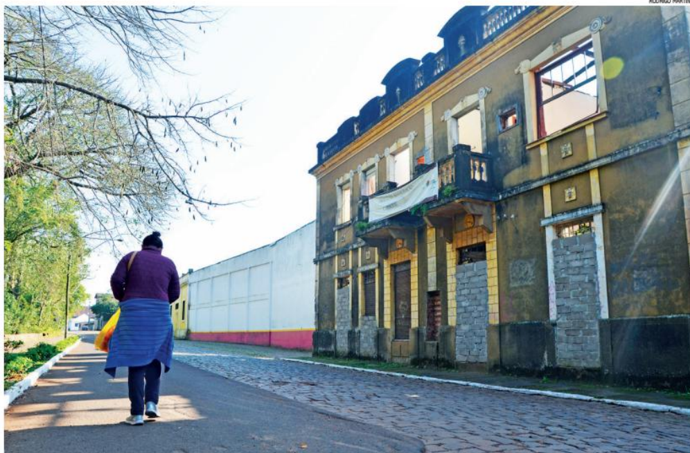
Casa de dois pisos, com 460 metros quadrados, foi destruída por um incêndio em 2013. Prédio passou a fazer parte do patrimônio público em dezembro
