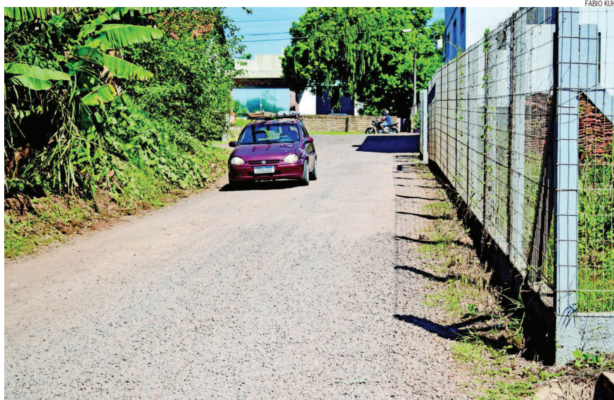
Moradores pedem alargamento da estrada. Conforme Executivo, parte do acesso passa por terrenos particulares
