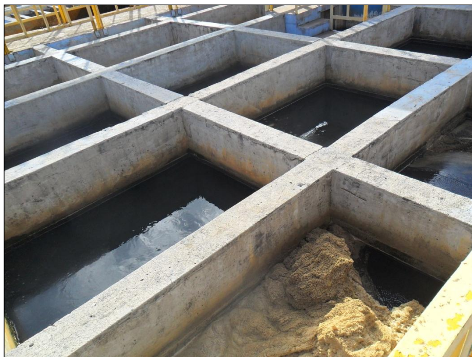
Figura 46: Problema de Formação de Flocos na Floculação.
