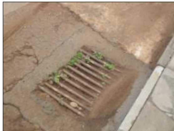
Figura 158: Detalhe da Boca de Lobo.
