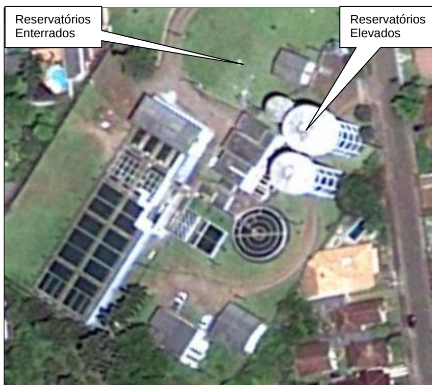
Figura 57: Área do Centro de Reservação ETA.
