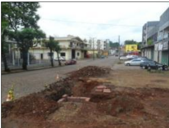
Figura 160: Visão Geral da Obra de Expansão do Sistema.
