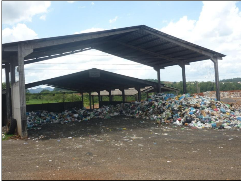
Figura 100: Vista da Área de Descarregamento dos Resíduos Sólidos no Galpão de Triagem.
