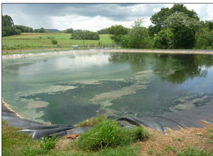
Figura 109: Lagoa Anaeróbia.
