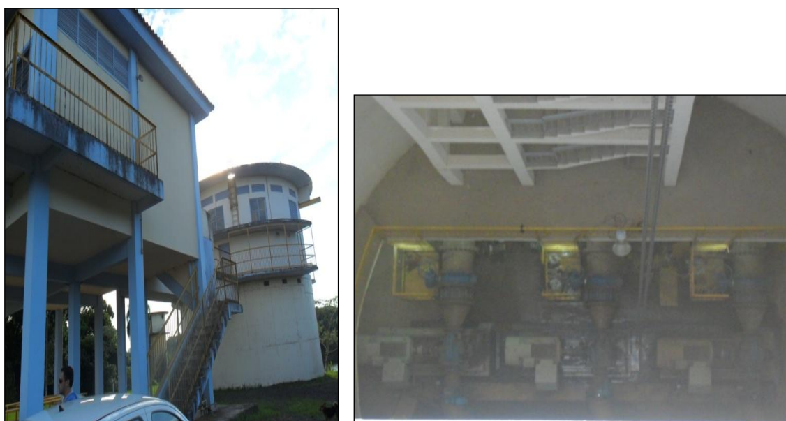
Figura 30: Sistema de Captação Nova.
