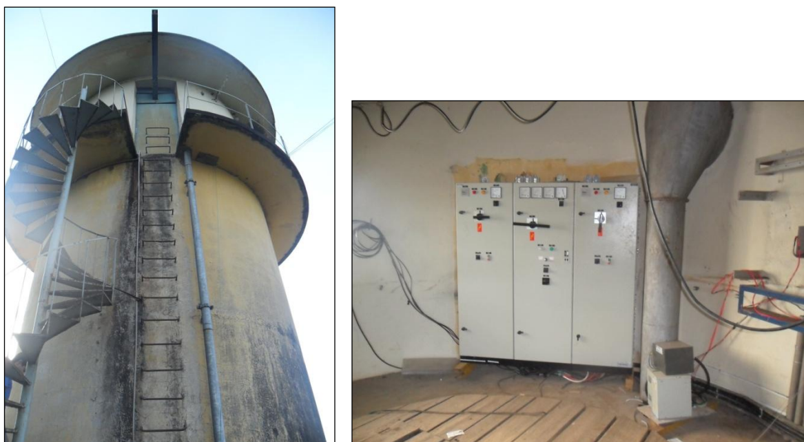
Figura 29: Sistema de Captação Antigo.
