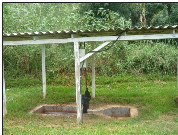
Figura 108: Calha Parshal.
