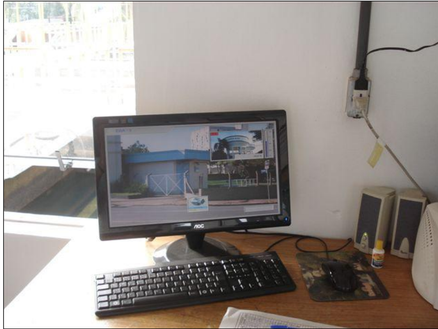
Figura 68: Telemetria dos Reservatórios.
