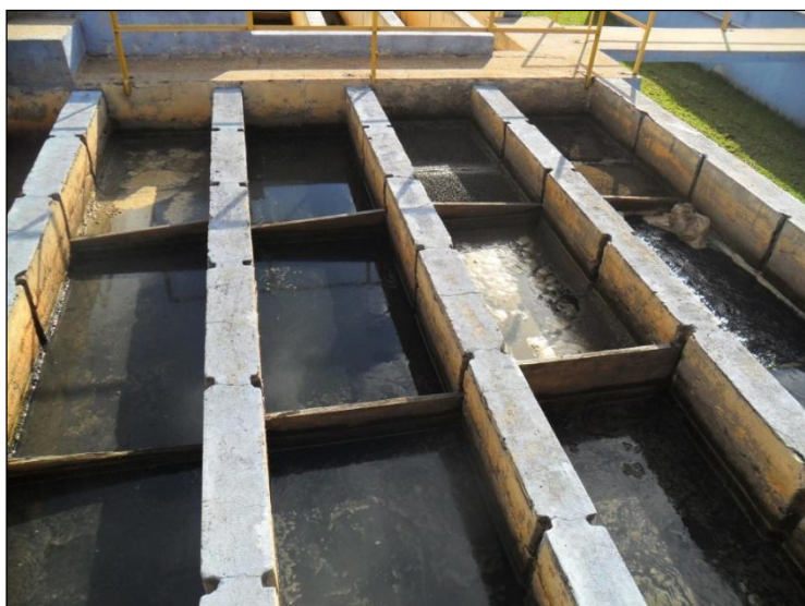
Figura 41: Problema de Formação de Flocos na Floculação.
