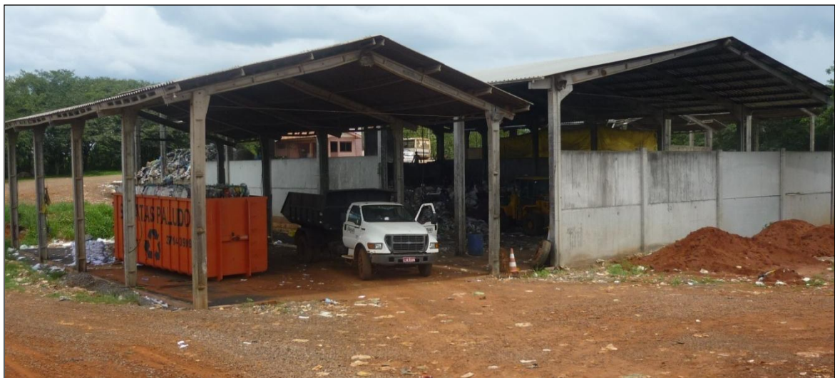
Figura 103: Vista dos Fundos do Galpão de Triagem e Caminhão Caçamba.
