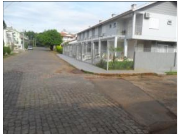
Figura 156: Continuação da Galeria Dupla Sob a Pista.
