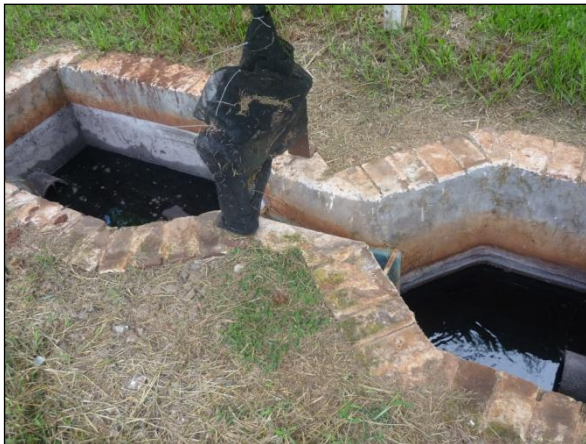
Figura 108: Calha Parshal.
