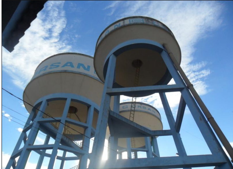
Figura 58: Reservatórios Elevados do Centro de Reservação ETA.
