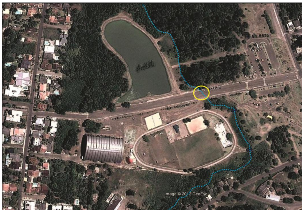
Figura 151: Detalhe da Localização do Bueiro.
