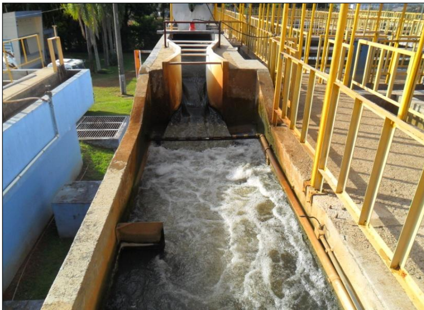
Figura 35: Calha Parshall.
