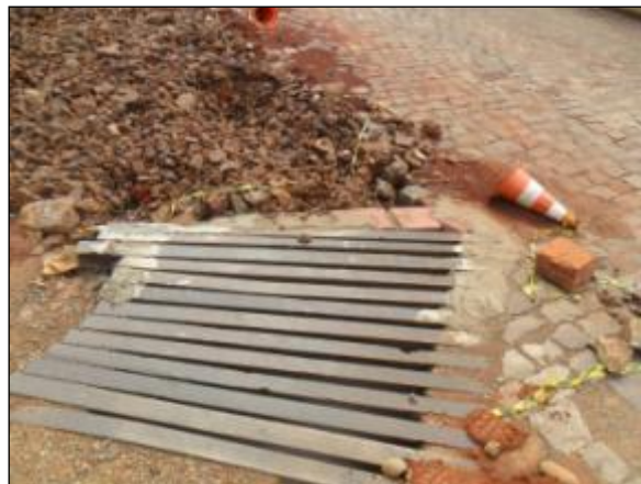
Figura 161: Boca de Lobo Sem Padrão.
