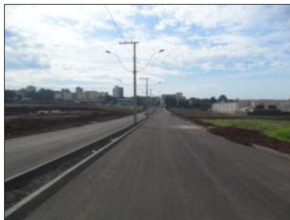
Figura 144: Visão Geral do Loteamento.
