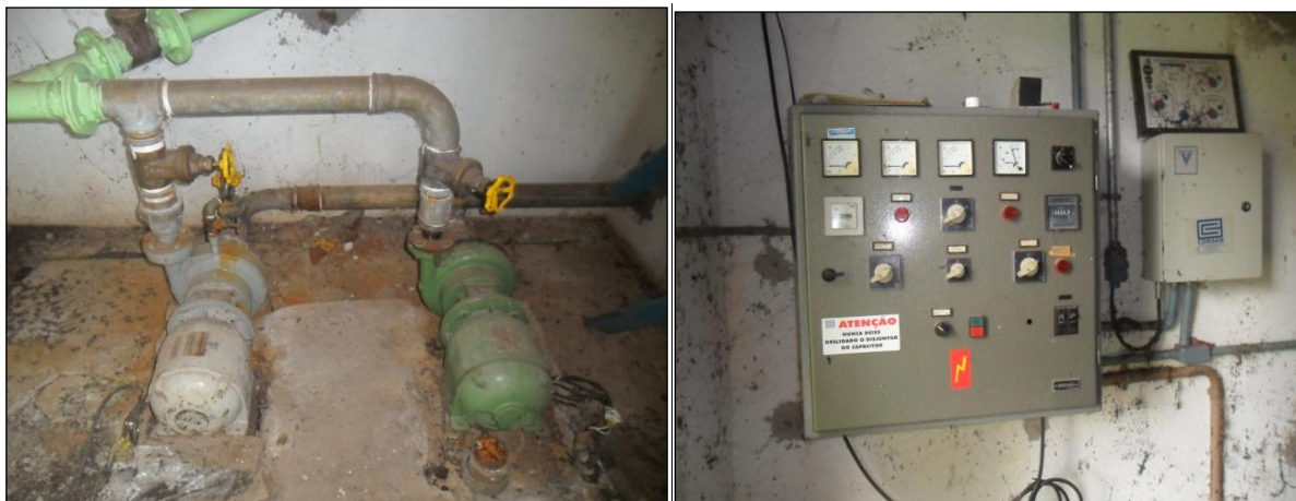
Figura 54: CMB's e Acionamento do 7º Recalque.
