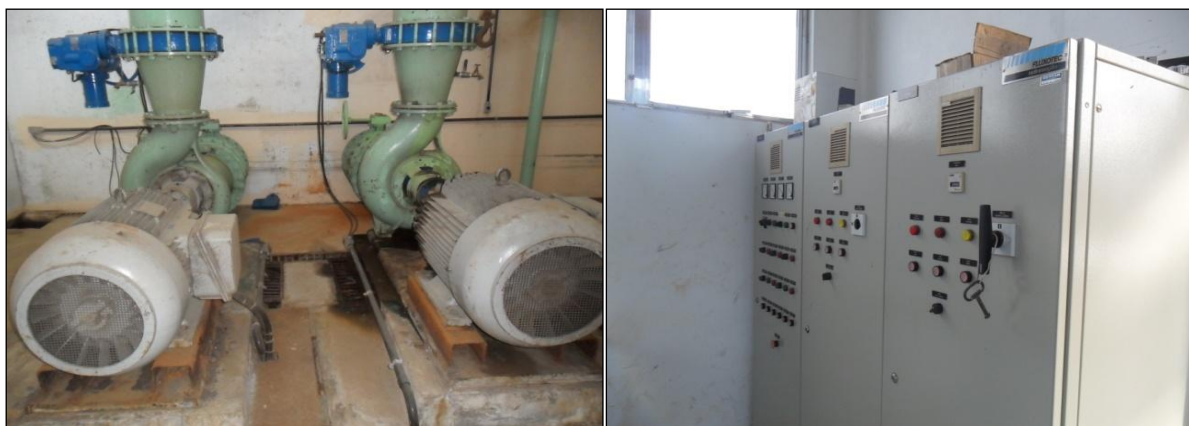
Figura 48: CMB e Acionamento do 2º Recalque.
