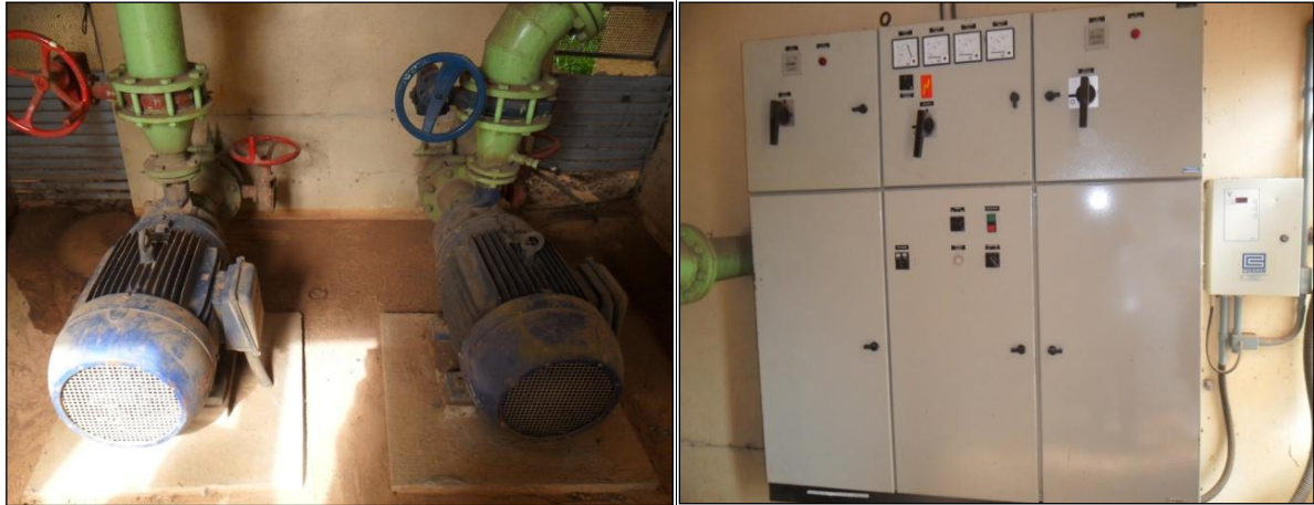
Figura 52: CMB's e Acionamento do 6º Recalque.
