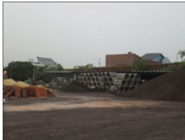
Figura 140: Tubulações de Concreto Estocadas no Pátio da SOSUR.
