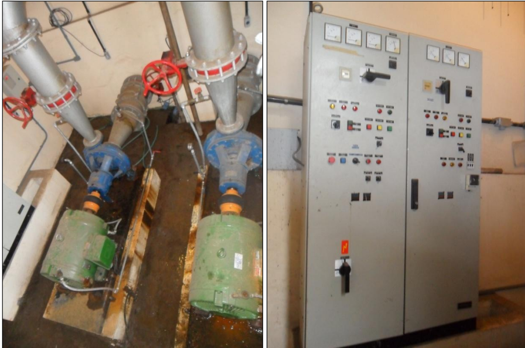
Figura 55: CMB's e Acionamento do 9º Recalque.
