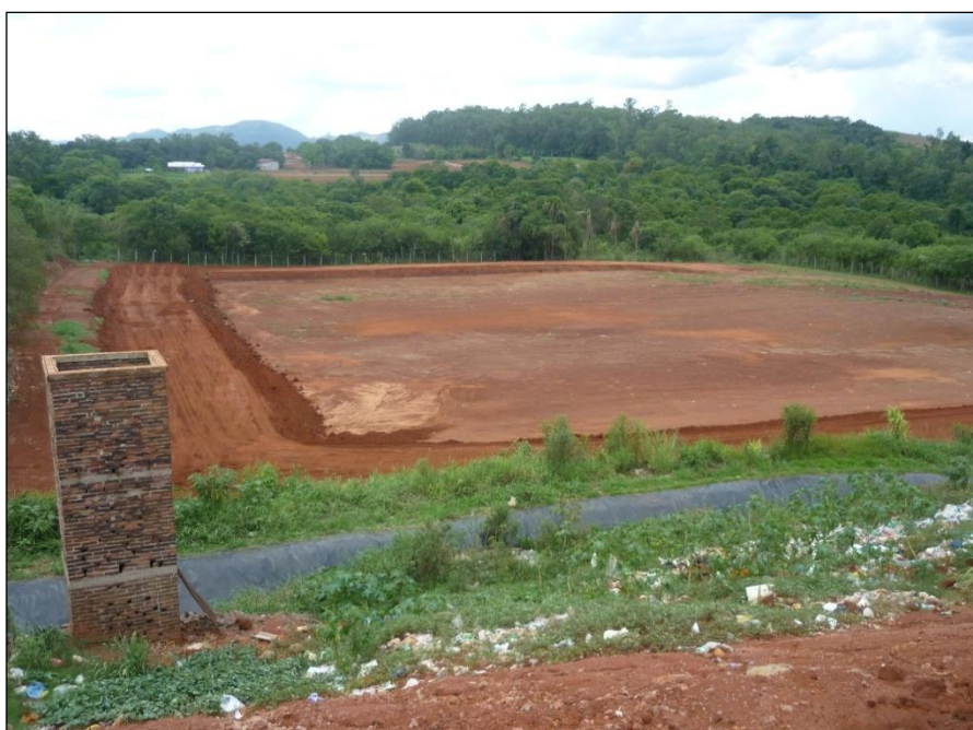
Figura 105: Implantação da Nova Célula do Aterro Sanitário.
