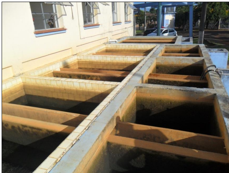
Figura 40: Filtração da ETA Antiga.
