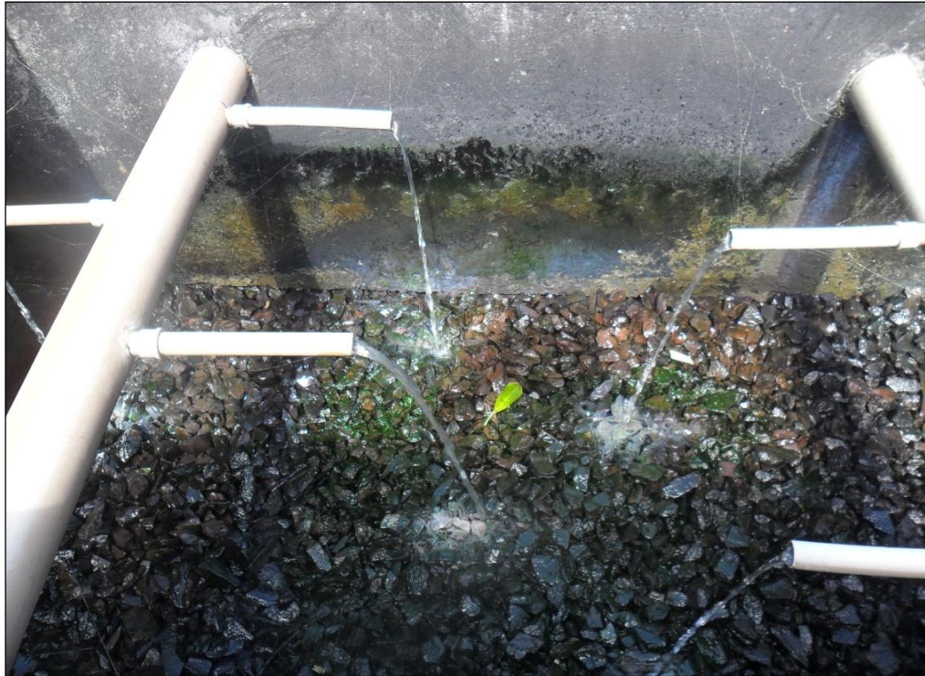
Figura 84: Dispersão do Efluente no Filtro Biológico.
