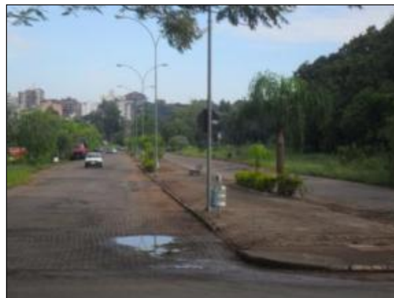
Figura 150: Canalização do Arroio do Engenho (Canteiro Central).
