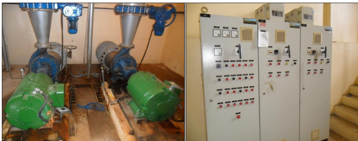
Figura 50: CMB's e Acionamento do 5º Recalque.
