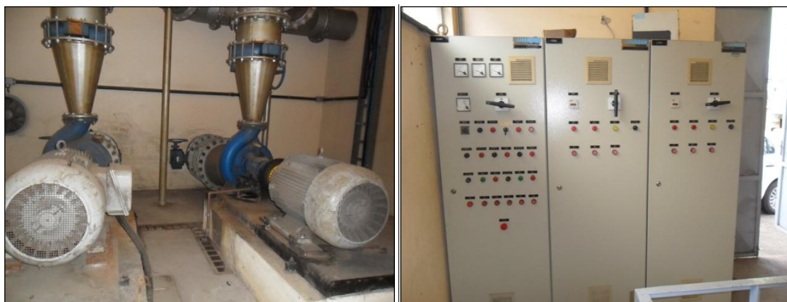
Figura 49: CMB's e Acionamento do 3º Recalque.
