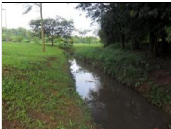
Figura 152: Visão Geral do Canal Afluente do Arroio Encantado.
