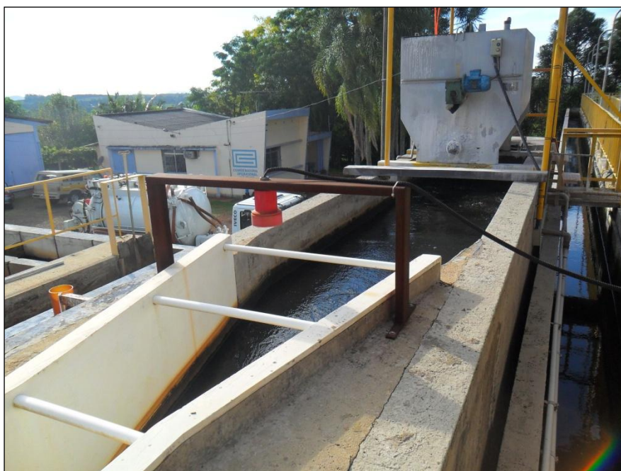
Figura 36: Medidor de Nível Ultrassônico.
