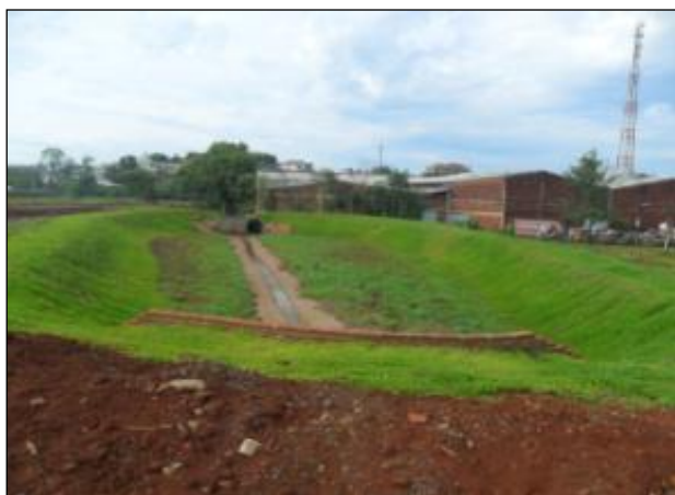
Figura 143: Bacia de Detenção.
