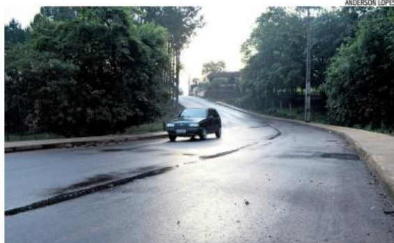
Na rua Pedro Petry, camada de asfalto está pronta, falta apenas a sinalização
