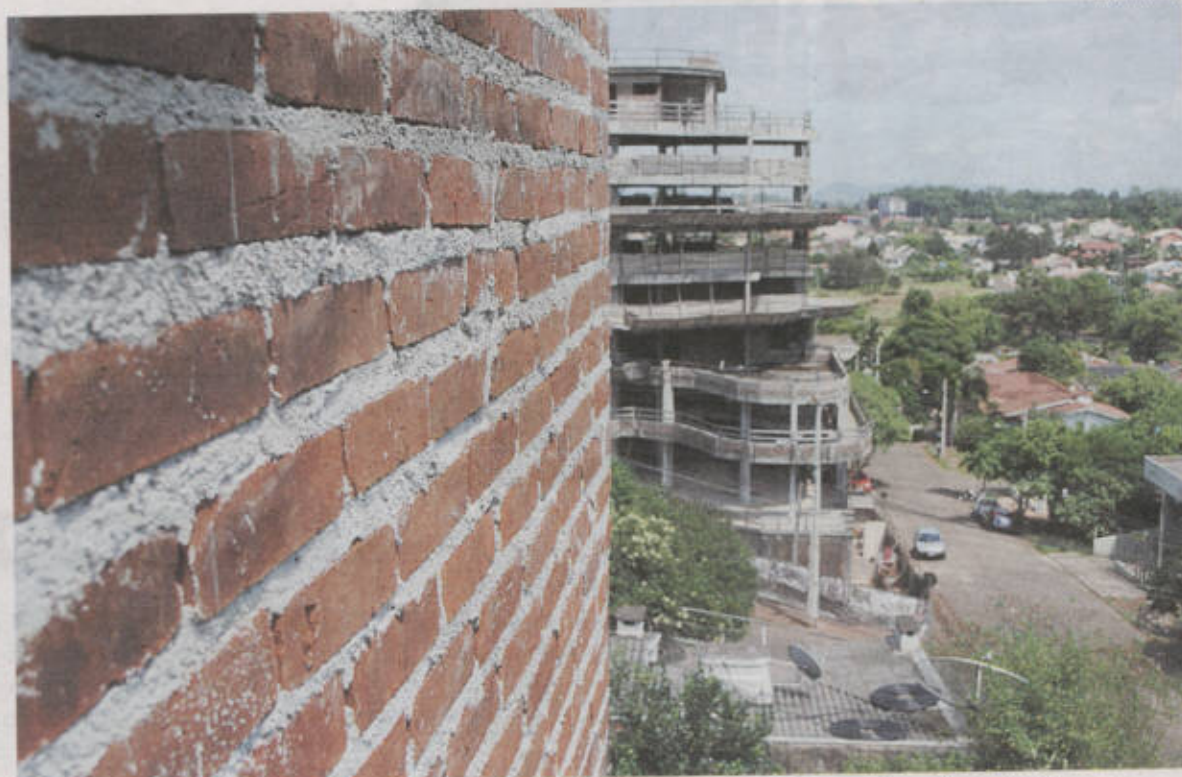
Para especialista, construções cada vez maiores e com prazos curtos de execução exigem bom planejamento
