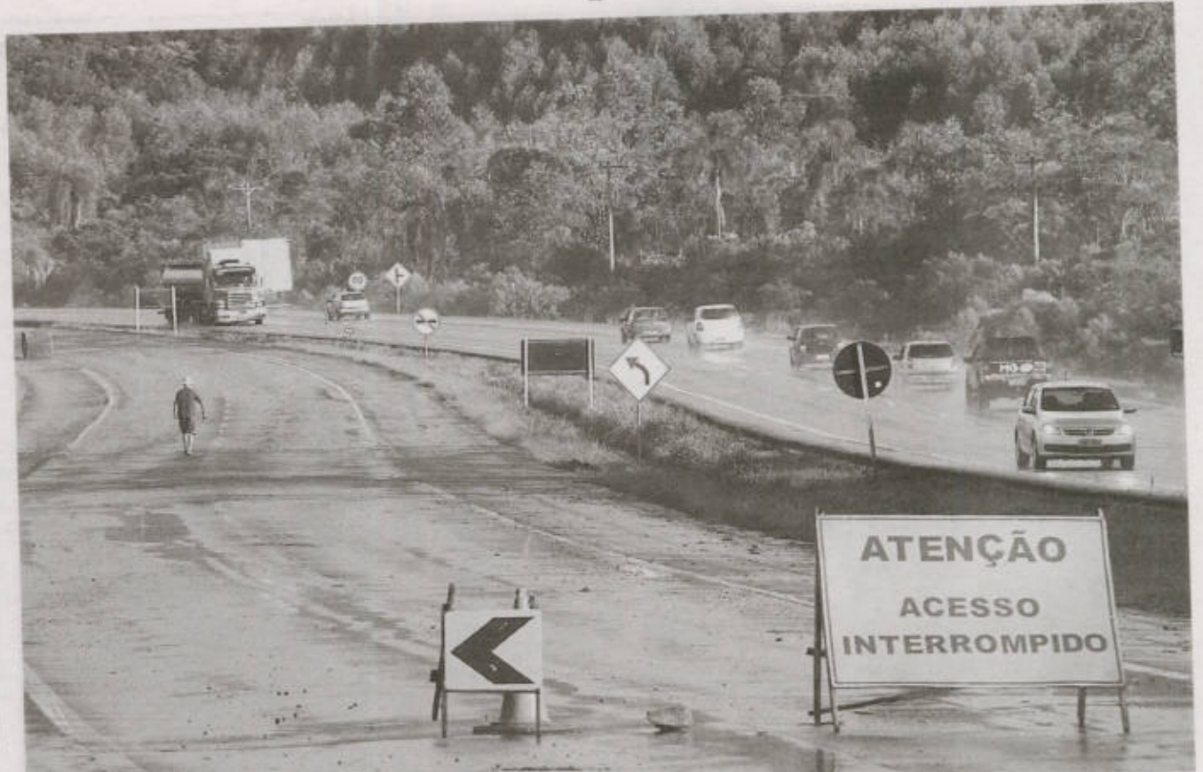
Trecho entre Bom Retiro do Sul e a praça de pedágio de Fazenda Vilanova será liberado hoje à tarde, às 13h30min
