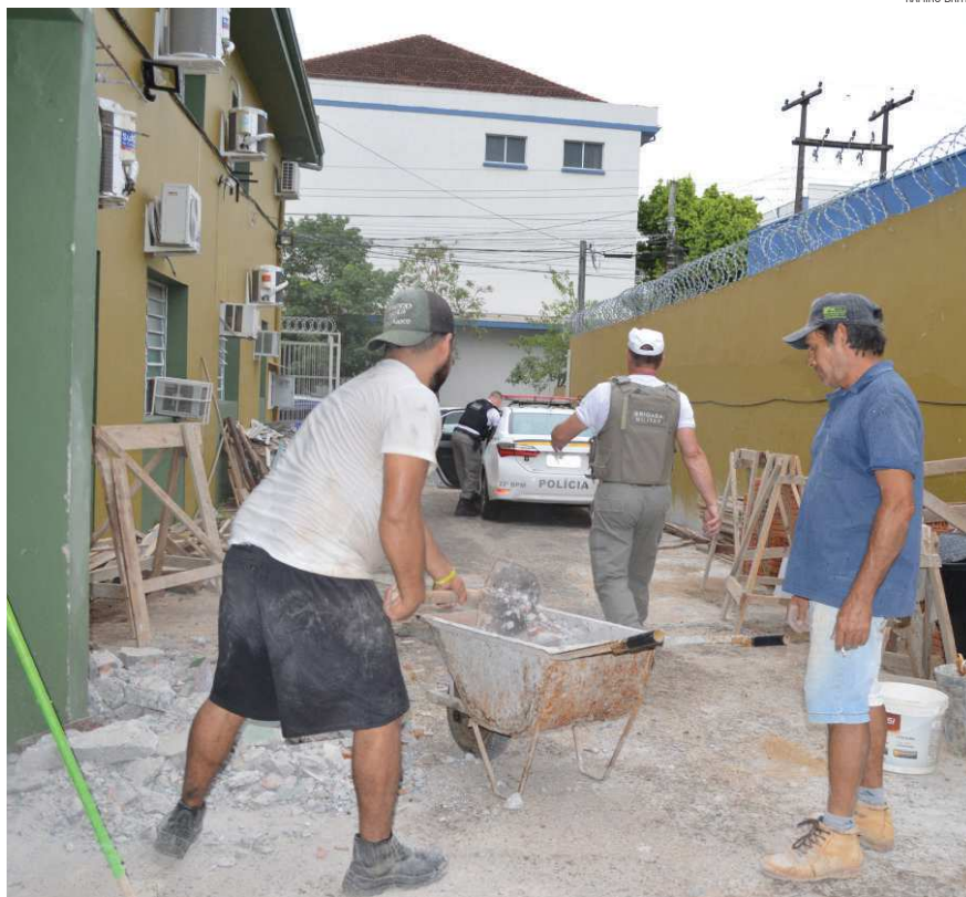
Demora na entrega de materiais para a construção atrasaram a obra. Faltam apenas pintura, portas e janelas.
