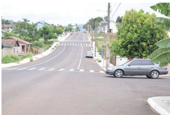
Financiamento foi feito para pavimentar três ruas, entre elas, a Alagoas
