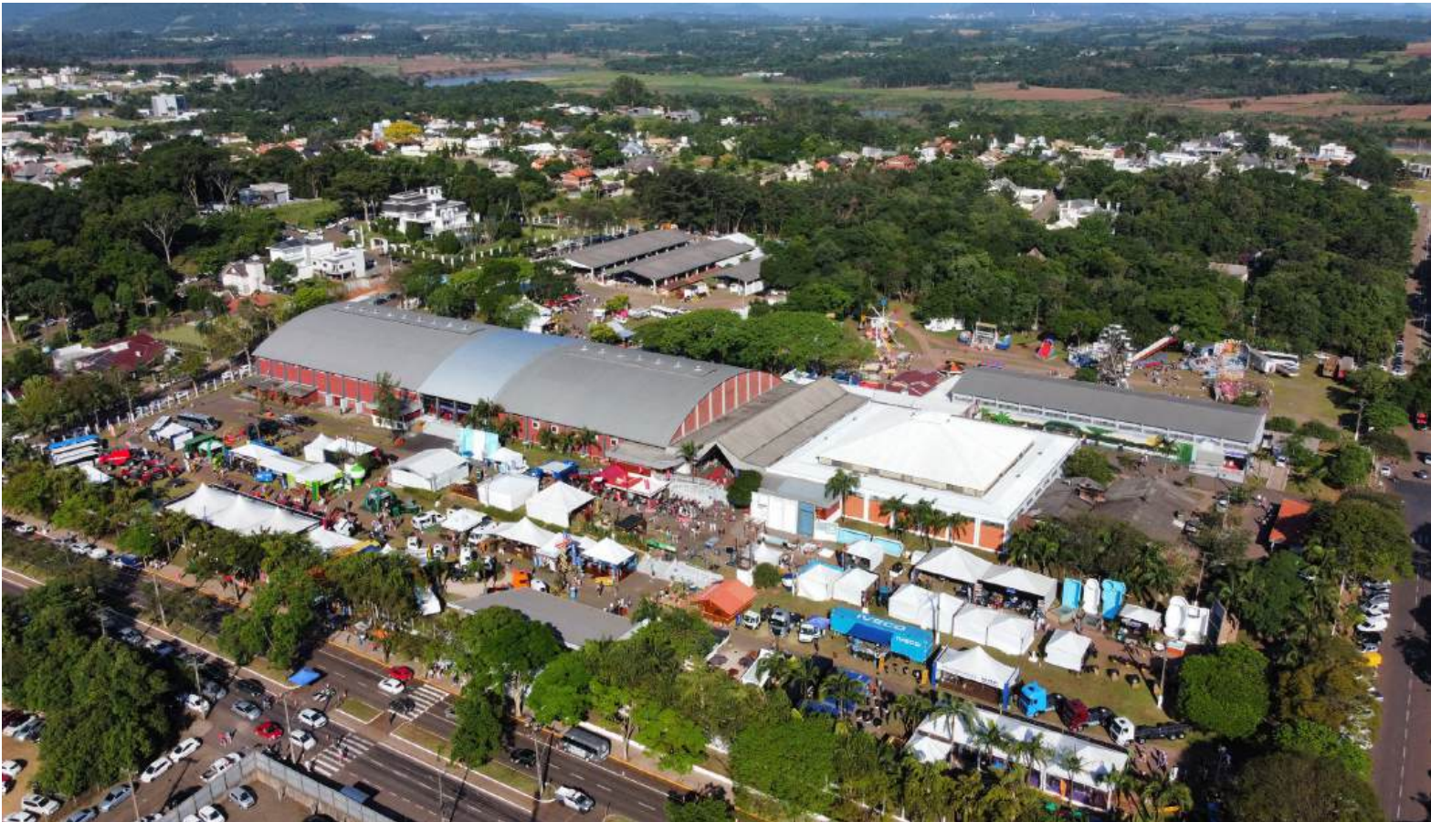
Obras irão modificar entorno do parque durante a Expovale + Construmóbil. Projeto também contempla a modernização dos pavilhões existentes
