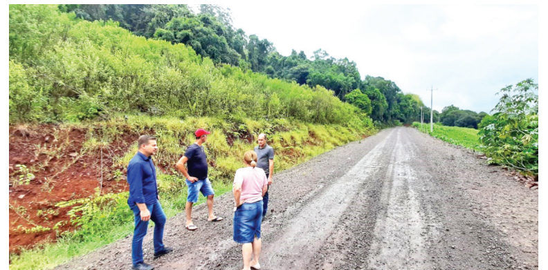
Na estrada de Linha São Roque as obras iniciam dia 10 de janeiro
