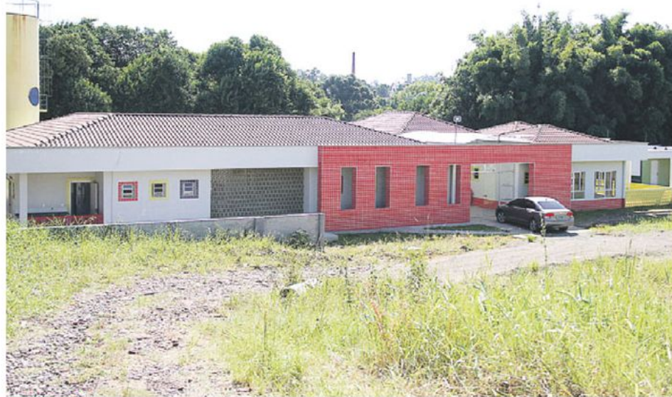
FINALIZAÇÃO: cercamento da creche será iniciado nesta semana
