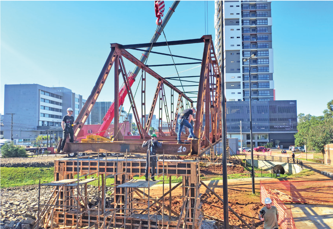
Com mais de 40 toneladas e 40 metros de vão livre, a estrutura histórica foi instalada com o apoio de guindastes
