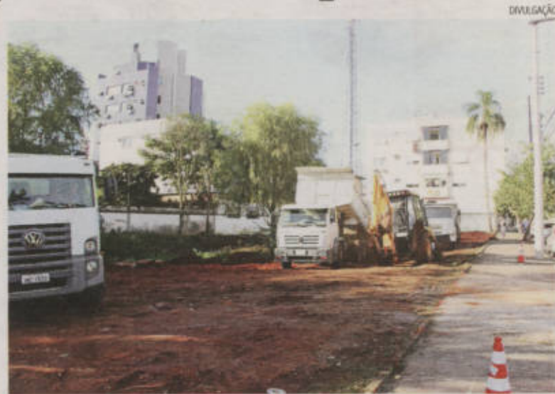
Serviços de terraplenagem no terreno começaram nesta semana
