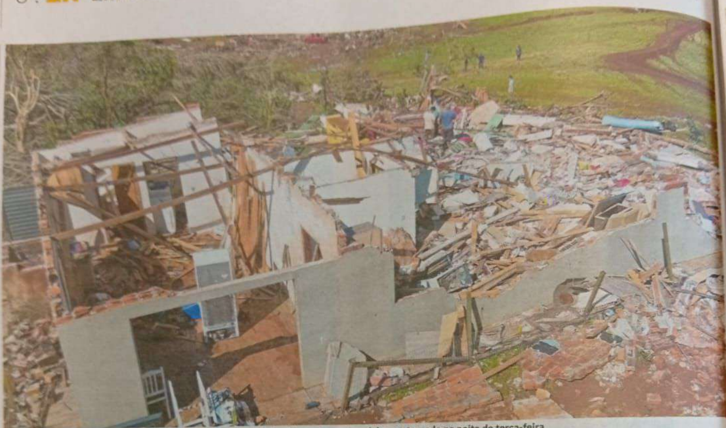
Estrutura de residência foi severamente danificada em área atingida no noroeste gaúcho por tornado na noite de terça-feira
