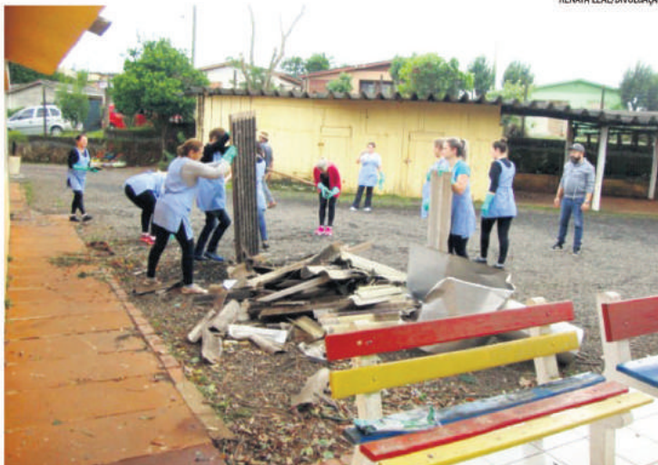
Em Lajeado, força do vento destelhou a Slan no bairro Santo Antônio. Aulas foram canceladas
