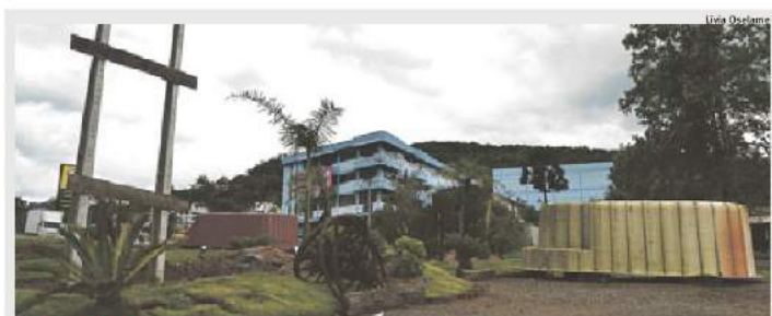
ESTRAGOS: piscinas e outdors foram deslocados com o vento
