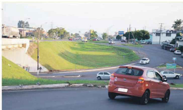
Viaduto inaugurado há mais de seis anos segue com a sinalização precária. Moradores se queixam de carros na contramão
