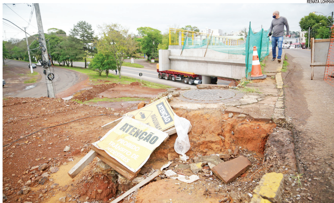
Último dia de obra no viaduto da Benjamin foi em 12 de agosto. Situação do trecho preocupa pedestres
