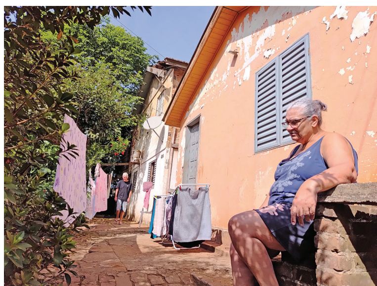
Maria Claudete da Silveira, 62, viu sua casa de dois andares ser tomada pela água que chegou a ultrapassar três metros acima do telhado
