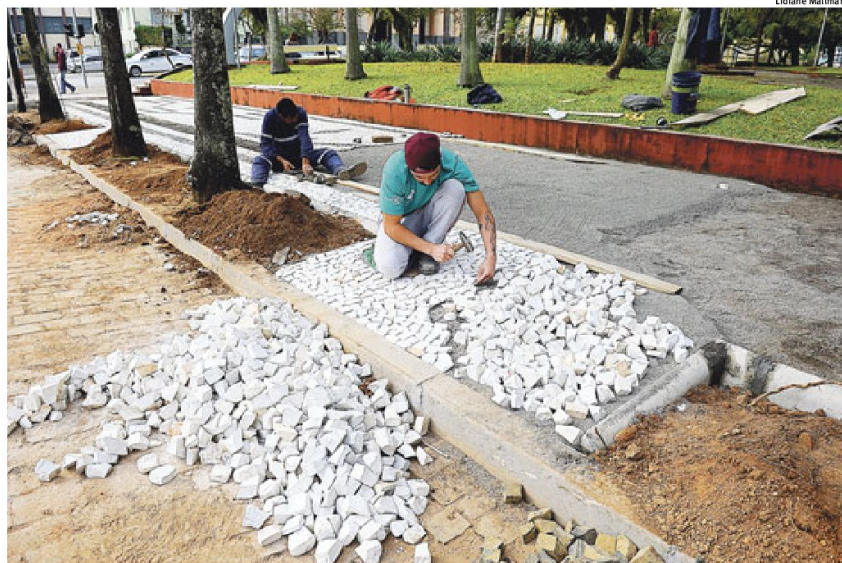
CALÇADA: fase atual do trabalho na Praça da Matriz é de colocação de pedras portuguesas
