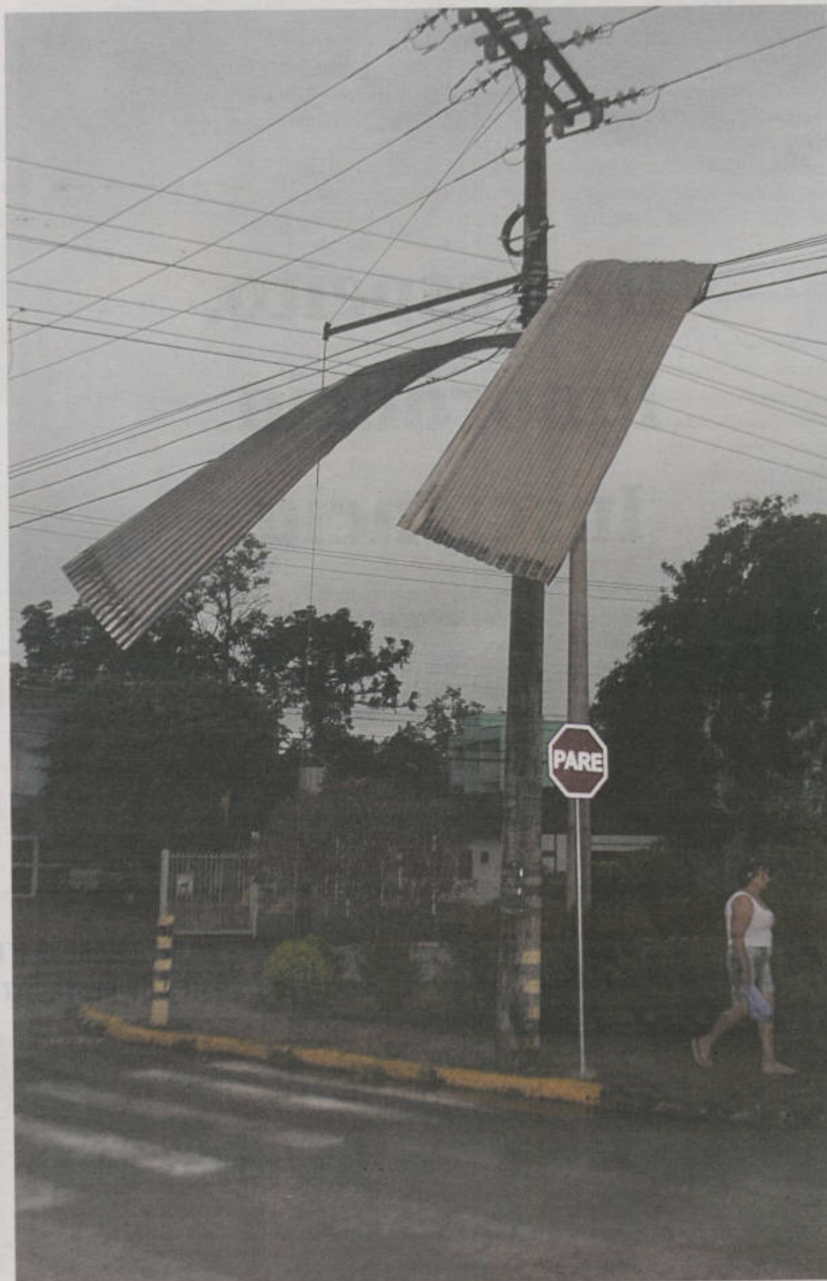
Em Moinhos, telhas de zinco da comunidade Nossa Senhora Conceição ficaram presas nos fios de alta tensão
