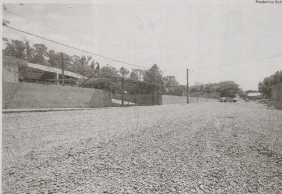
No Bairro Auxiliadora, pavimentação próxima de escolas facilita acesso de estudantes
