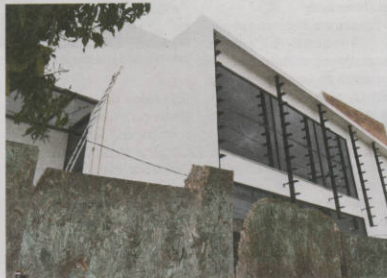
Entrega deveria ter sido feita em 2012. Erros na execução atrasaram o projeto
