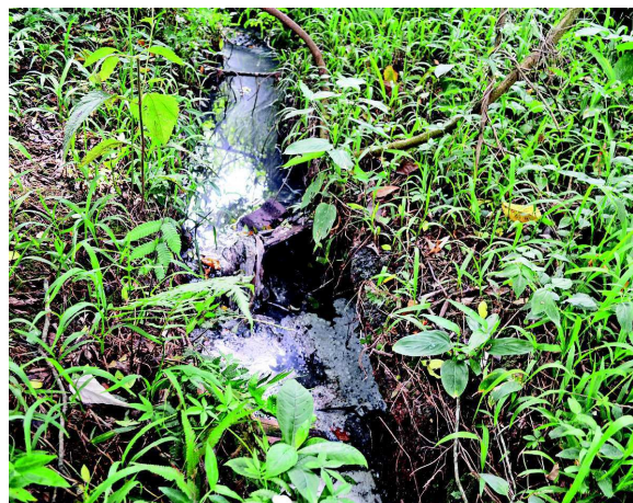
Sujeira levada pelo esgoto a céu aberto se instala no corrimento sem canalização
