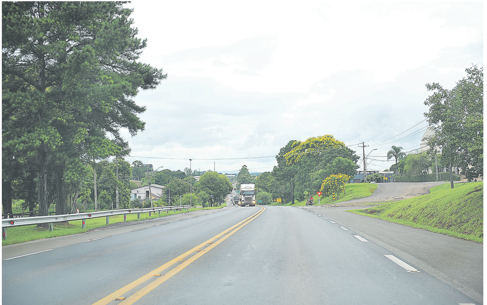
Local do viaduto projetado entre Olarias e Montanha, agora de mão dupla, segundo o prefeito Marcelo Caumo
