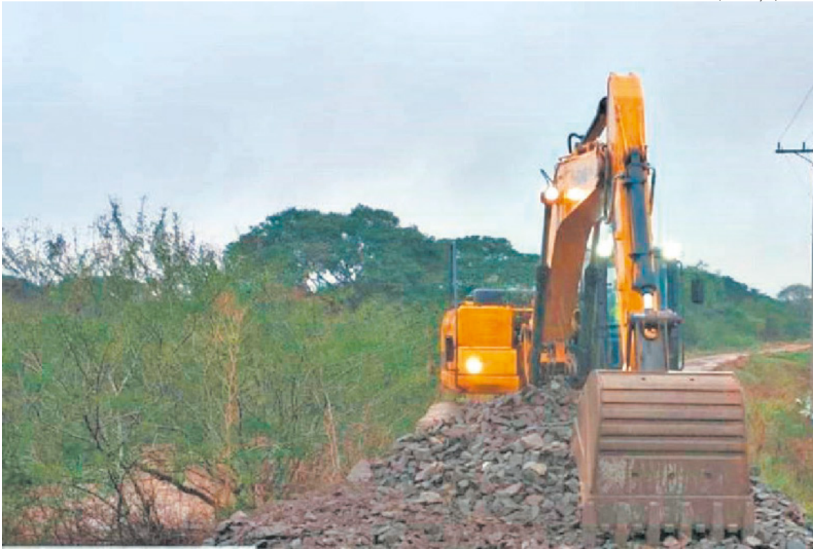
Reparos emergenciais são feitos em várias frentes para tentar ajudar no escoamento da água na cidade
