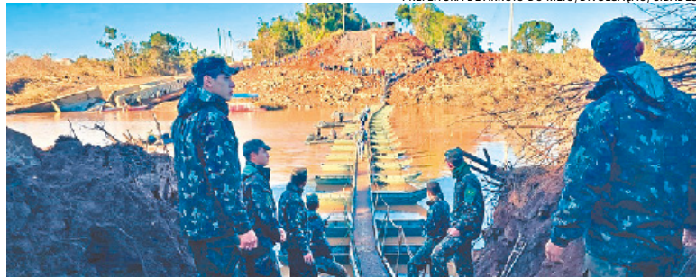
Estrutura vai funcionar 24h por dia para o trânsito de pedestres
